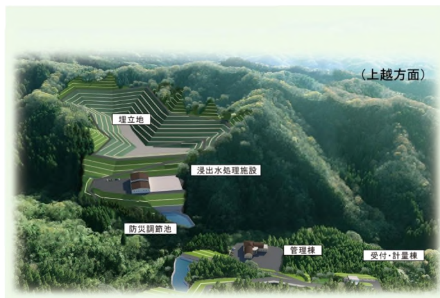
図 1.4-4 下中山地区埋立地の施設配置イメージ
