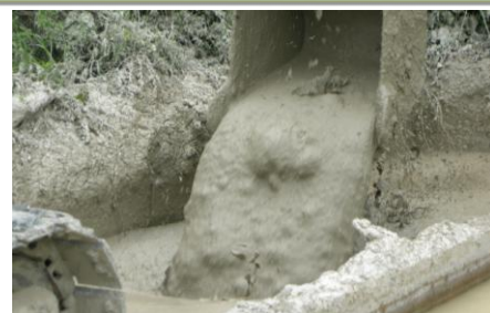
生コン残さ(スラッジ)
